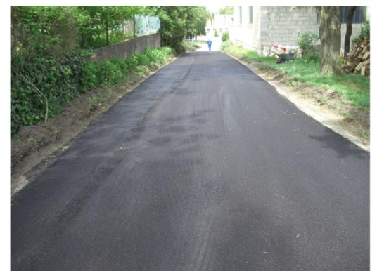
Die oberösterreichische Firma Mikrobelaag GmbH, die auch ein Teilstück der LH 25 Richtung Senning erneuert hatte, führte die Arbeiten durch. Zuerst mussten die Straßenränder gegrädert werden. Danach wurde die Straße gewaschen, um die Verschmutzungen zu entfernen und den Halt des Asphalt zu gewährleisten, sowie die Spalten und Risse freizulegen. Im Anschluss wurde die über die Jahre und Nutzung entstandenen Schäden in der Fläche versiegelt und eine ca. 1 cm dicke Asphaltenschicht aufgebracht.
